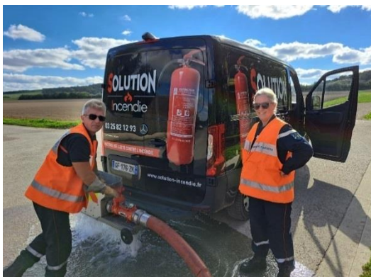
Contrôle des points d'eau incendie
